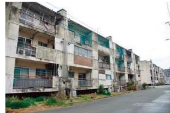
共同住宅の空き家
