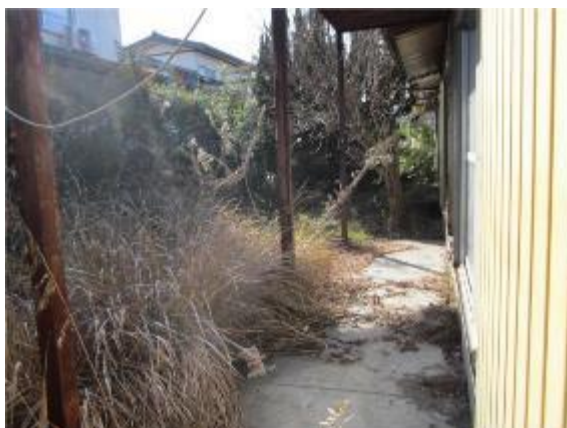
雑草が繁茂した空き家
